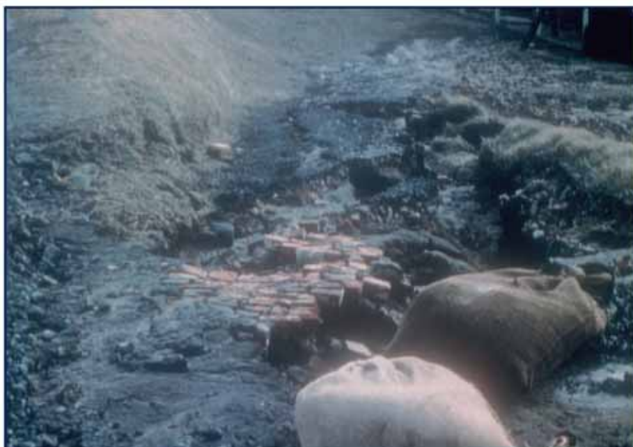
Schaden an einer Binnenrampe
