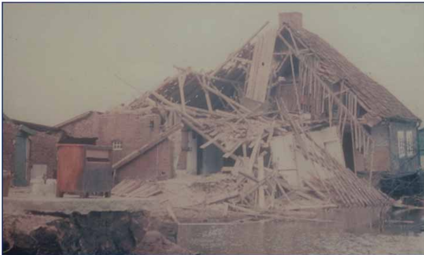
Achterdeich - durch Deichbruch zerstörtes Gebäude
