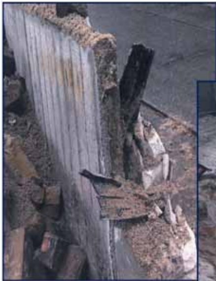
Die vorhandene Hochwasserschutzwand während des Abrisses (Bullenhausen)
