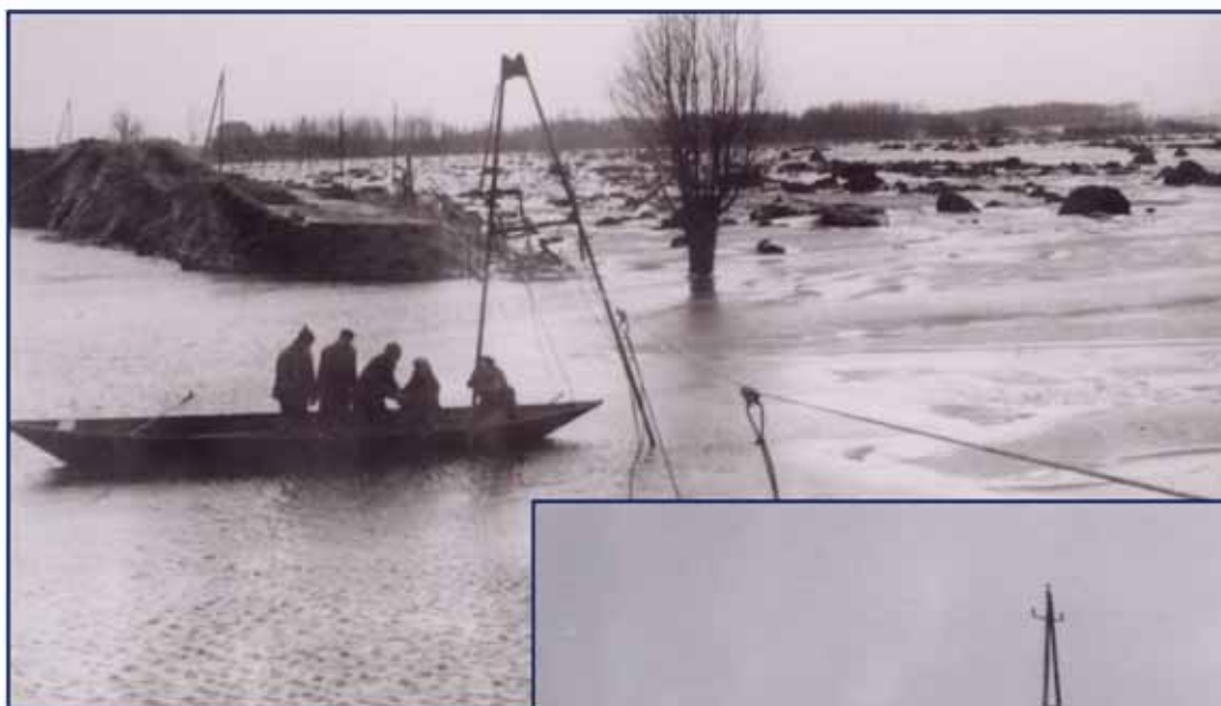
links: Deichbruchstelle bei Achterdeich
