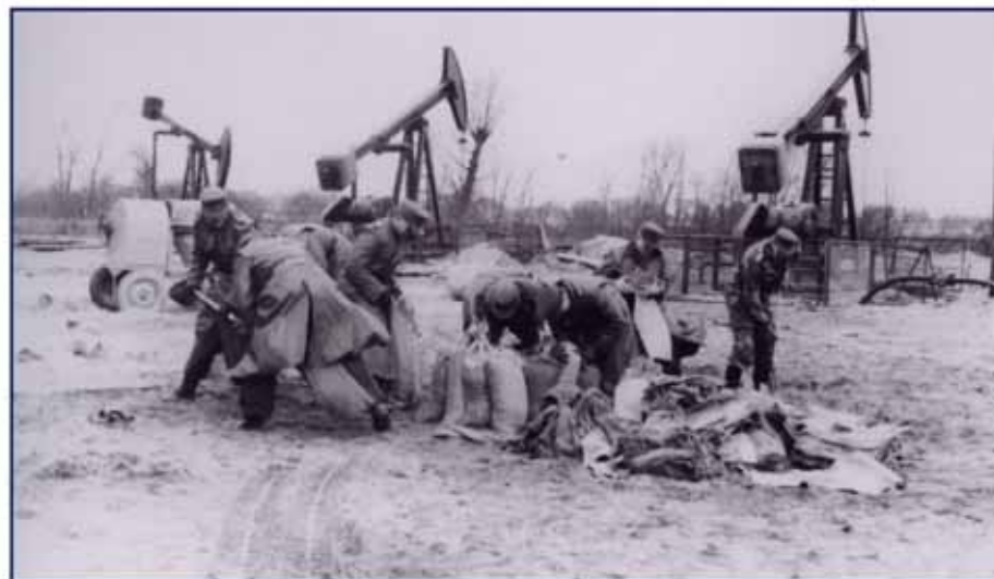
Sicherung der Erdölförderstelle bei Meckelfeld
