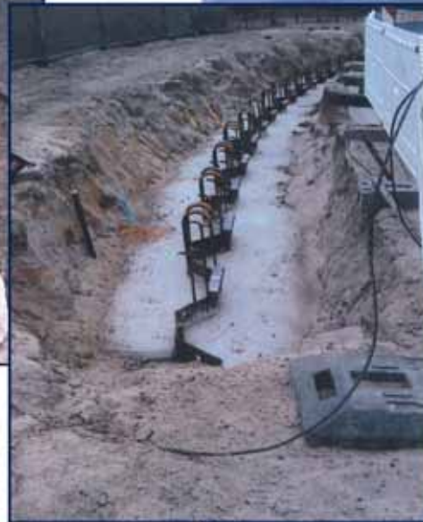
Der Bau der neuen Hochwasserschutzwand (Bullenhausen)
