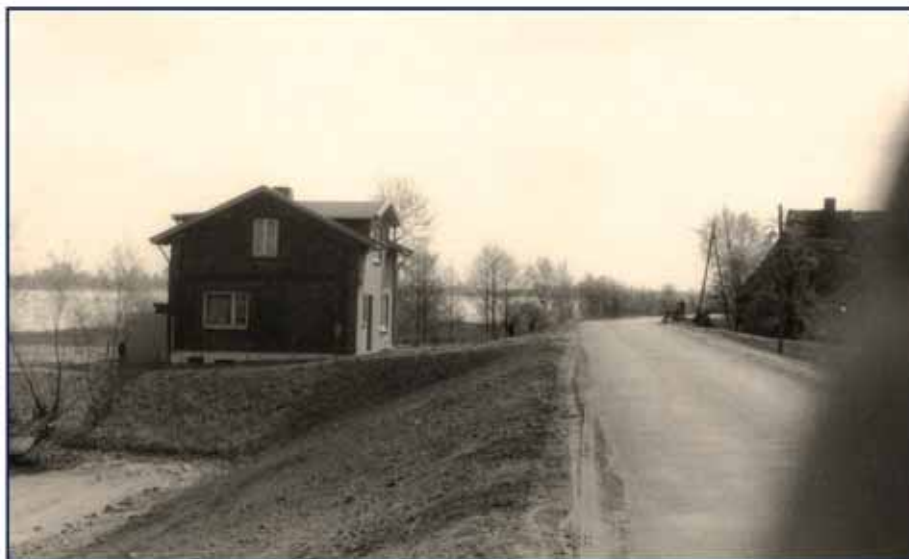
Wiederhergestellter Deich an der Bruchstelle Bullenhausen – Außenböschung
