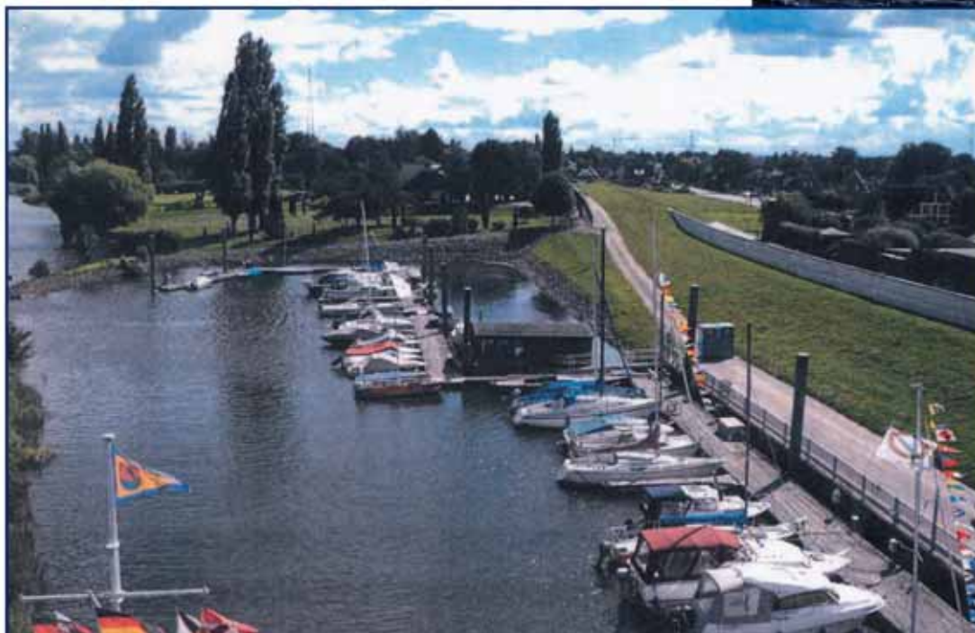
Hafen Bullenhausen mit neuer Hochwasserschutzwand
